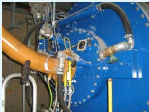
Рис. 3. Генератор горячих газов, работающий на угольной пыли
