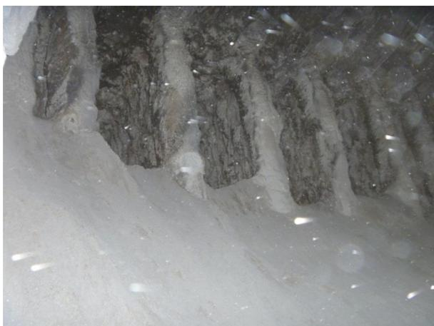
Рис. 2.3. Состояние фестона и пароперегревателя после 8-ми суток работы.
