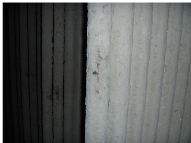
Рис. 2.4. Состояние поверхностей нагрева после расшлаковки.
