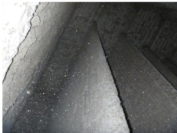
Рис. 2.2. Состояние экранов и ширм (радиационная часть КУ) после 8-ми суток работы.
