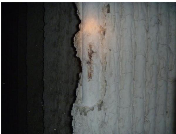
Рис. 2.1. Состояние ширм (радиационная часть КУ) после 8-ми суток работы.
