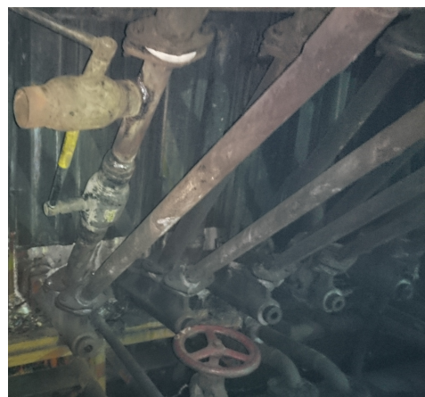
Рис.3. Подвод вторичного воздуха и угольной пыли от коллекторов.
