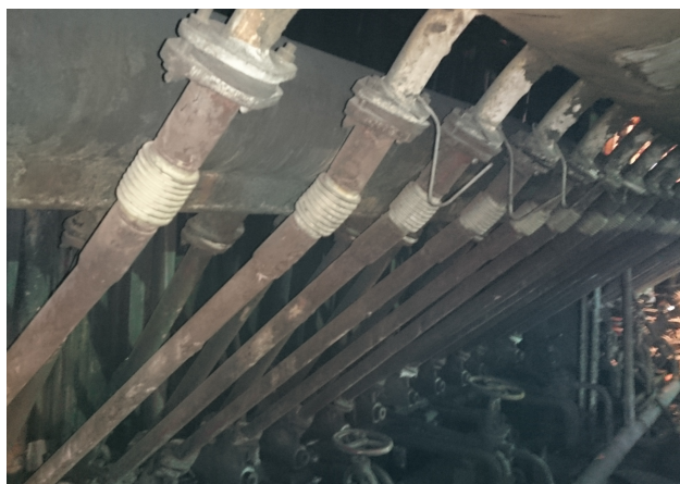
Рис.3. Подвод вторичного воздуха и угольной пыли от коллекторов.
